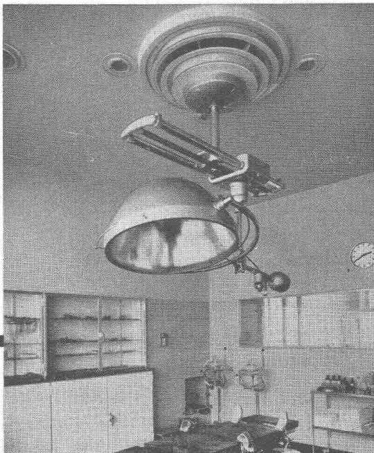
Klimaanlage «System Häusler» in Operationssaal eines Spitals
