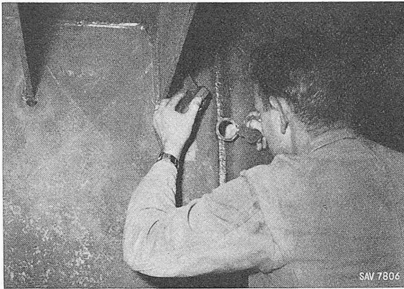
Bild 42. Schweissnahtkontrolle von Auge mit der Lupe
