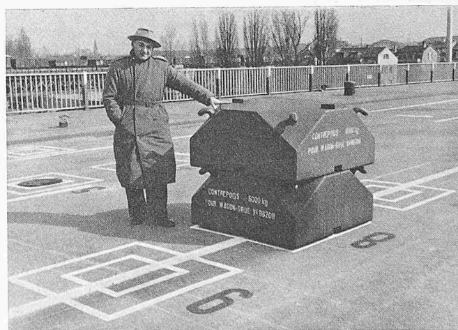
Bild 52. Einzellast von 12 t
