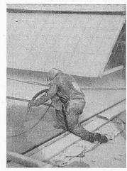
Bild 37. Reinigung des Deckbleches mit dem Sandstrahlgebläse
