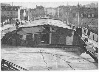
Bild 39. Fahrbares Schutzdach auf dem Fahrbahn-Deckblech
