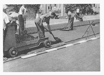
Bild 40. Einbau des Non-Skid-Belages auf der Grossbasler Zufahrtsrampe
