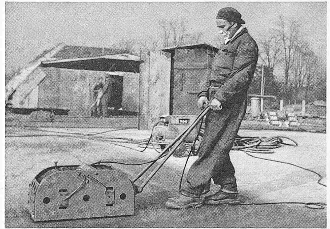
Bild 38. Reinigung des Deckbleches mit der Schleifmaschine System von Arx, Sissach (Bilder 37 bis 39 phot. A. Lehmann, Basel)
