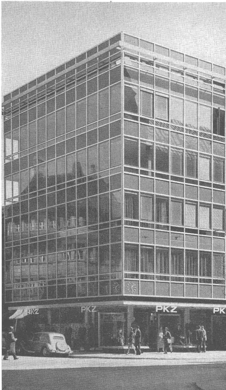
(Haus Waltisbühl, Zürich Architekt S.I.A. R. Zürcher)
