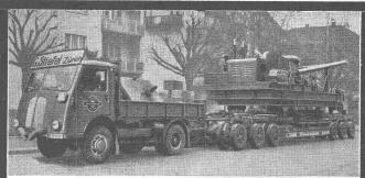
Transport eines 54 Tonnen schweren Rammenfusses auf dem 24fach bereiften Schwertransportanhänger mit dem starken Allrad-Zugwagen mit
