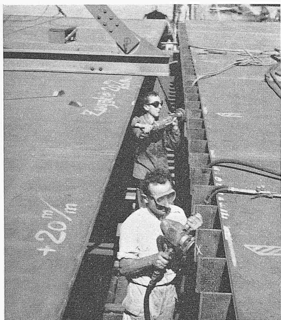
Bild 25. Bearbeiten eines Passtosses zum Ausgleich der Schrumpfung der Schweissung der Montagestumpfstösse der orthotropen Platte. Solche Passtösse wurden alle drei bis vier Platten angeordnet. Montagefortgang von rechts nach links. Beim Plattenstück links ist ein Teil der Aufhängevorrichtung zum Versetzen sichtbar
