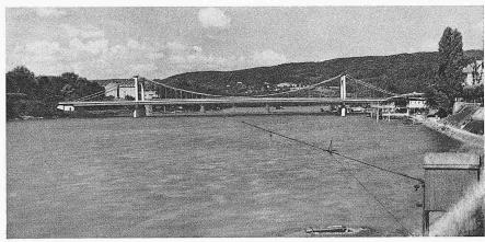
Bild 3. Ebenso, jedoch Spannweite der Mittelöffnung 160 m
