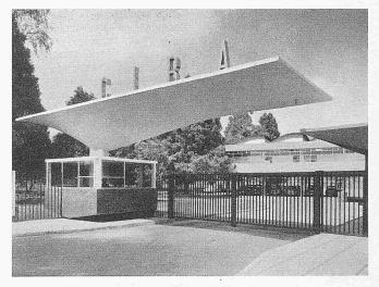
Bild 2. Untersicht des 11 m auskragenden Daches
