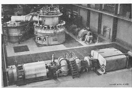
Bild 3. Heissluftturbinenanlage mit geschlossenem Kreislauf von 12500 kW in der Zentrale St-Denis bei Paris. Der Einbau in das bereits vorhandene Kraftwerkgebäude verlangte getrennte Aufstellung von Hochdruck- und Niederdruckgruppe. Im Hintergrund: Hochdruckgruppe (rechts), Lufterhitzer mit Ueberdruckölfeuerung (Mitte) und Verbrennungsluft-Vorwärmer (links)
