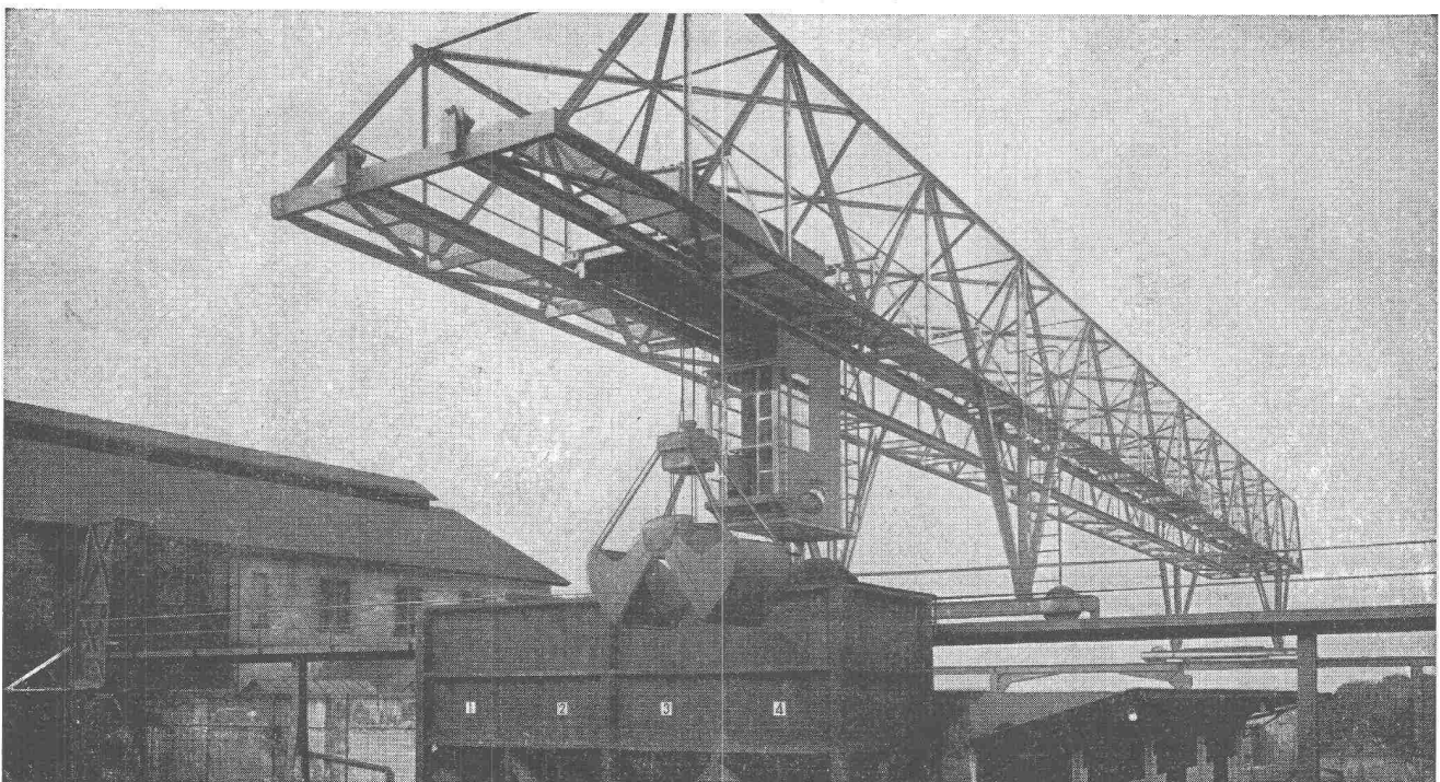
Verladebrücke in Schweisskonstruktion 2,5 t Tragkraft, 46 m Länge
