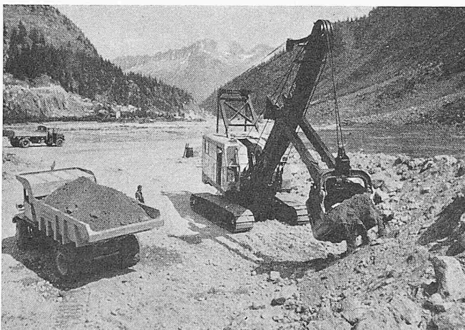
Bild 1. Bagger P&H 1055, 318 PS, 90 t, Löffel 2,7 m³. Links Rückwärtskipper 31 TD, 300 PS, beladen 40 t, Mulde 12 m³
