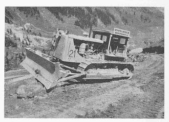
Bild 2. Bulldozer Caterpillar D 8, Gewicht 22 t, Motorenleistung 190 PS
