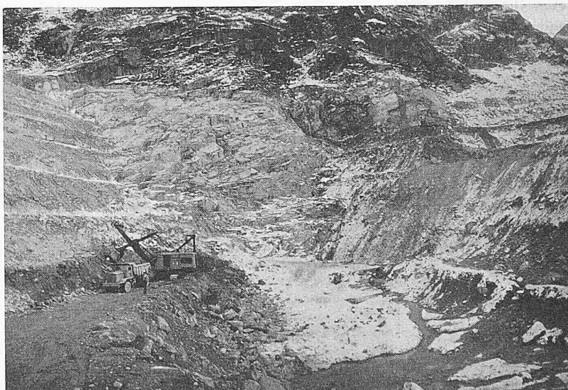
Bild 12. Baugrube für den Dammkern; Stand der Aushubarbeiten Ende Oktober 1956
