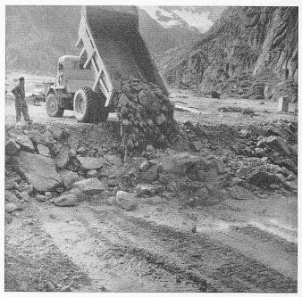
Bild 8. Schüttvorgang beim Einbau nassen Stützkörpermaterials und einer Schütthöhe von  $2.0\,\mathrm{m}$  (Grossversuch)
