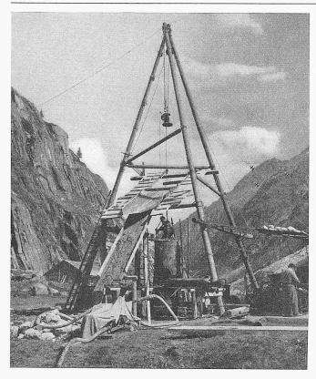
Bild 3. Bohreinrichtung der 80 cm Sondierbohrung
