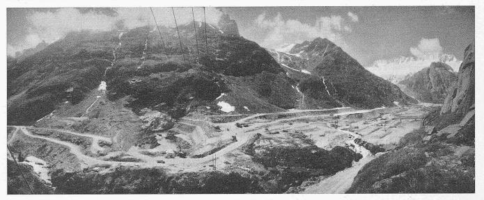
Bild 4. Sperrstelle und Staugebiet. Im Vordergrund der Aushub im Bereiche der Dammaxe, damit der Dichtungskern auf den Fels abgestellt werden kann. Das Aushubmaterial, das für den Dammbau wieder zur Verwendung kommt, wird im zukünftigen Staugebiet auf Zwischendeponie gelegt. Im Hintergrund rechts ist ein Teil des Fangdammes zu erkennen.
