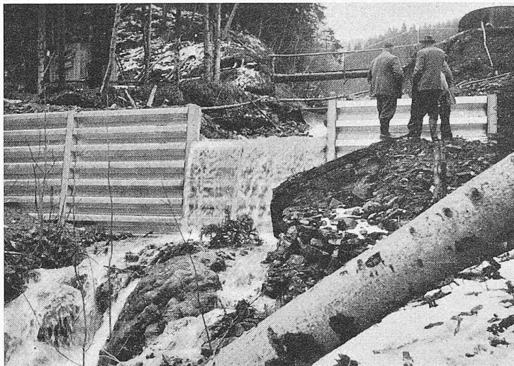
Bilder 3 und 4. Ansichten der Armco-Sperre im Steinibach ob Hergiswil (auf Bild 4 im Hintergrund Ende der Hangleitung)
