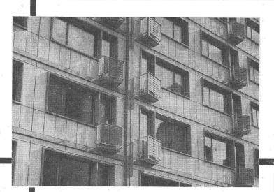
Ausfachung eines Beton-Skelettbaues
