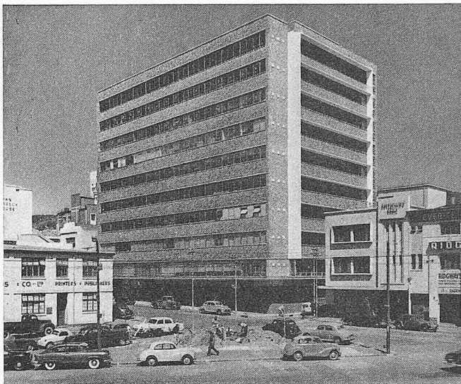
Geschäftshaus der Motors & General Building Ltd. in Cape Town. Balkenrost-Konstruktion, Nutzlast 730 kg/m 2 . Aufgehängtes Hochparterre
