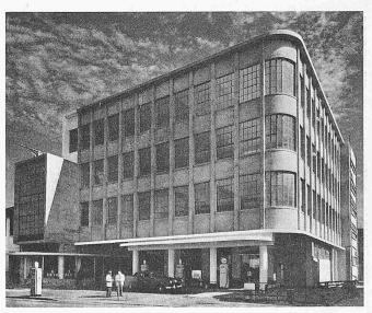
Garagebau in Cape Town, kombiniert mit Fabrikräumen in den oberen Geschossen: Eisenbetonskelett
