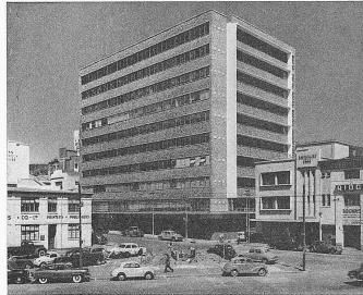
Geschäftshaus der Motors & General Building Ltd. in Cape Town. Balkenrost-Konstruktion, Nutzlast 730 kg/m². Aufgehängtes Hochparterre
