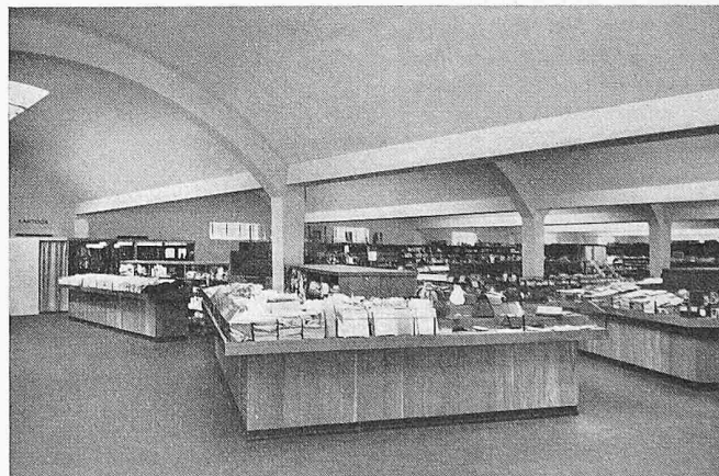
Farmer-Koop-Gebäude in Morresburg. Schalendächer mit zwei Spannweiten von je 30,5 m, Breite 10,5 m, Schalendstärke 6 cm
