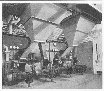
Bild 4. Escher Wyss Zweiflammrohrkessel je  $105\,\mathrm{m}^2$  Heizfläche, Betriebsdruck 13 atü mit mechanischen Feuerungen Escher Wyss-Doby
