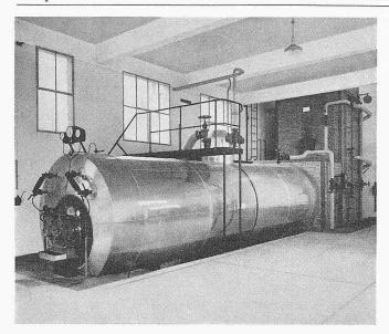
Bild 3. Escher Wyss Einflammrohrkessel mit Oelfeuerung, isolierte Bauart, Dampferzeugung 3,3 t/h, Betriebsdruck 18 atü
