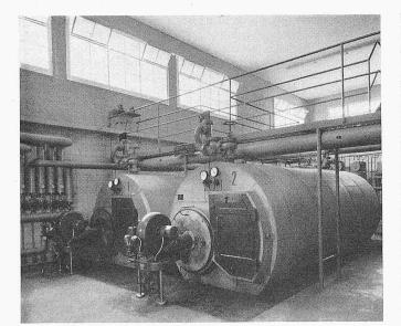
Bild 8. Zwei Escher Wyss Flammrohr-Rauchrohrkessel Typ «R» für eine Heisswasser-Industrieheizung, Heizfläche je 65 m², Betriebsdruck 6 atü
