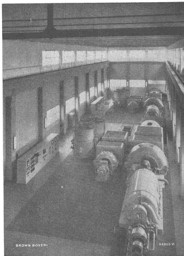
Bild 2. Blick in den Maschinenraum des zurzeit grössten Gasturbinenkraftwerkes der Welt in Livorno mit einer Gesamtleistung von 50 MW. Jede der beiden zweiweligen Gruppen besteht aus einem Hochdruckaggregat (Bildmitte) mit einer Drehzahl von ca. 4500 U/min und einem Niederdruckaggregat, enthaltend den elektrischen Generator mit einer Leistung von 31,25 MVA bei \cos \varphi = 0,8 ; Drehzahl 3000 U/min (rechts im Bild). Als Anlaufzeit der beiden Maschinengruppen vom kalten Zustande aus bis zur Uebernahme der Vollast werden nur ca. 20 min benötigt.
