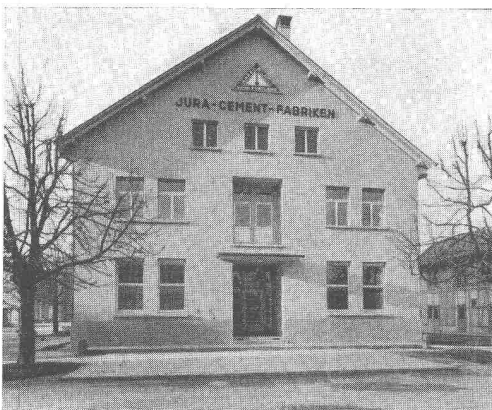
Jura-Portland-Cementfabrik, Wildeg, Verwaltungsgebäude Malermeister: A. Cavinato, Holderbank
