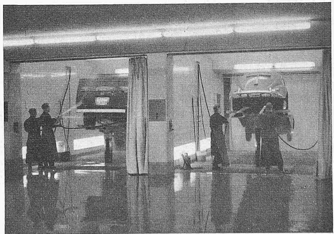
Bild 12. Zwei von den drei Waschplätzen mit speziellen Säulenliften und mit weitem Licht- und Luftschaft durch das Erdgeschoss bis auf Dachhöhe
