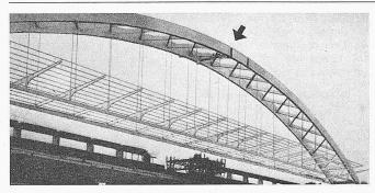
Bild 1. Ein Zwillingsbogen hat die steife Scheitelgelenkverbindung (Pfeil) erhalten, die ihn zum Zweigelenkbogen macht; an diesem hängt die Tragkonstruktion des Flachdaches
