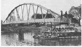
Bild 1. Rohrbrücke von 76 m Spannweite bei Nottingham
