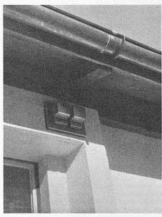
Bild 3. Beispiel für die Aussenmontage von zwei Dämmerungsschaltern für die Steuerung der Beleuchtung eines Innenraumes
