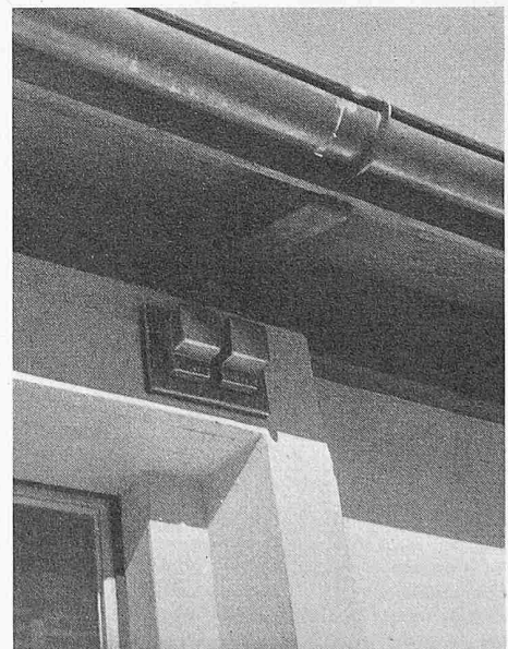
Bild 3. Beispiel für die Aussenmontage von zwei Dämmerungsschaltern für die Steuerung der Beleuchtung eines Innenraumes
