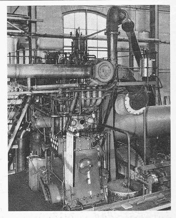
Bild 16. Der Einzylinder-Versuchsmotor 1 RS 58 mit Abgasturbolader von Brown Boveri auf dem Versuchstand
