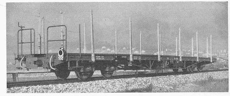
Bild 5. Plattformwagen Typ OM7 der Rhätischen Bahn
