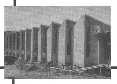
Eisenbetonbau, vollständig mit PORA-Platten ummantelt
