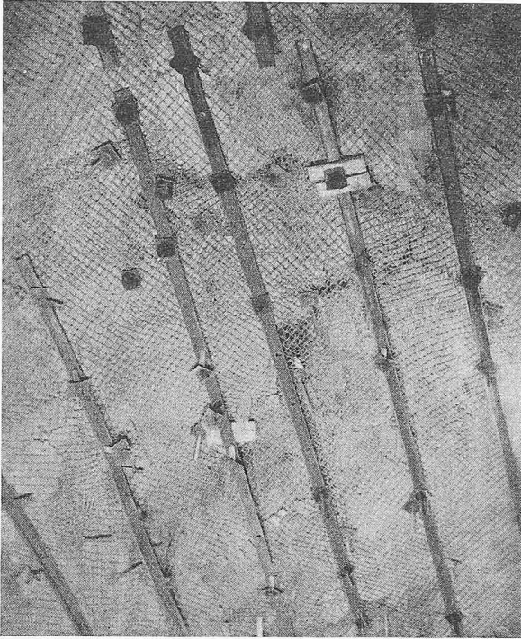
Bild 8. Ankerung an der Decke der Krafthaus-Kaverne in Forçacava. Miss-erfolg, weil zu spät geankert wurde und Anziehen der Muttern von Hand erfolgte statt mit pneumatischer Impact Wrench
