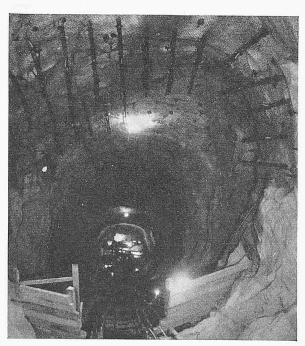
Bild 6. Ankerung durch Keilschlitzanker, Netz und Profileisen im  $45^{0}$  geneigten Schrägschacht des Kraftwerkes Forçacava (Brasilien);  $F=44~\mathrm{m}^{2}$
