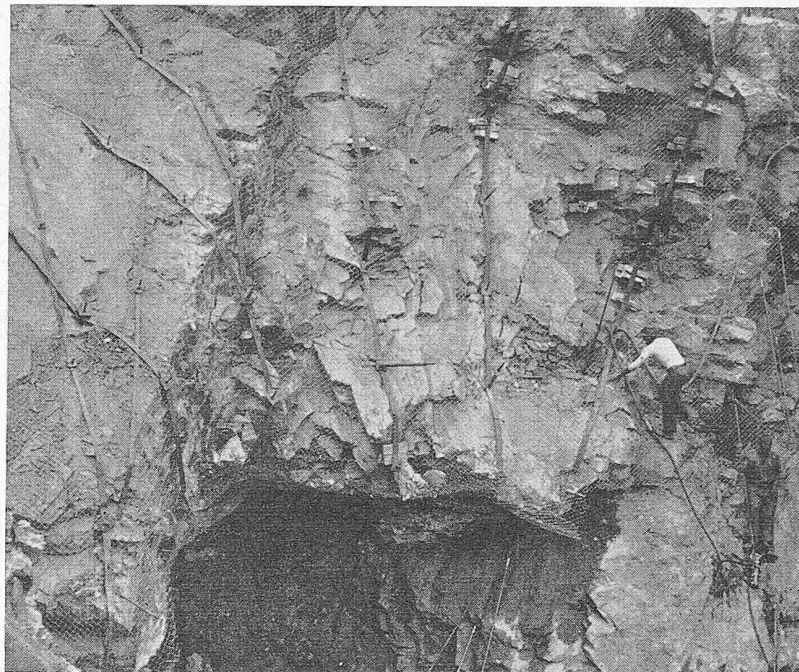
Bild 12. Versuche der schwedischen Eisenbahnverwaltung zeigen den schlechten Füllungsgrad injizierter Löcher
