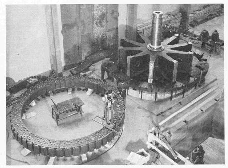
Bild. 47. Montage des Generator-Polrades im Maschinenhaus, Rechts Schichten der Blechkette eines Polradkranzes, links Ausreiben der Löcher für die Passchrauben. 4. Januar 1952
