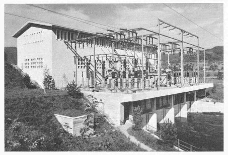
Bild 51. Maschinenhaus vom Unterwasser mit 150 kV-Freiluftschaltanlage. 1. September 1954
