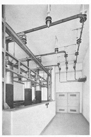
Bild 52. Wasserwiderstand 8,2 kV, 23 000 kW. 23. Oktober 1953
