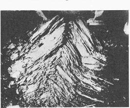
Bild 8 (links). Ausbruch für das Sohlgewölbe im Lebendungneis, Km 6,740 ab Südportal
