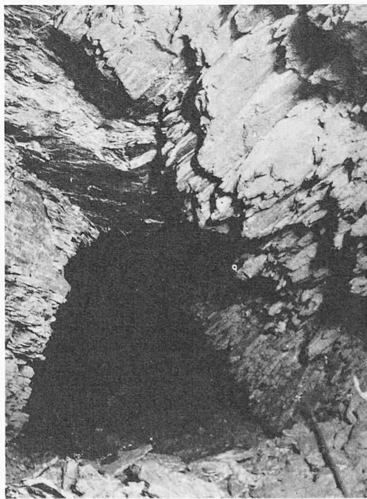
Bild 8 (links). Ausbruch für das Sohlgewölbe im Lebendungeis, Km 6,740 ab Südportal
