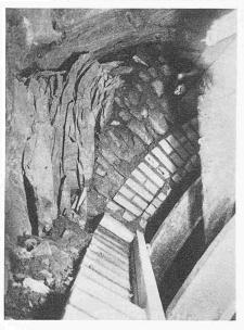
Bild 6. Entspannung (Bergschläge) im Vollausbruch, Km 9,672 ab Nordportal
