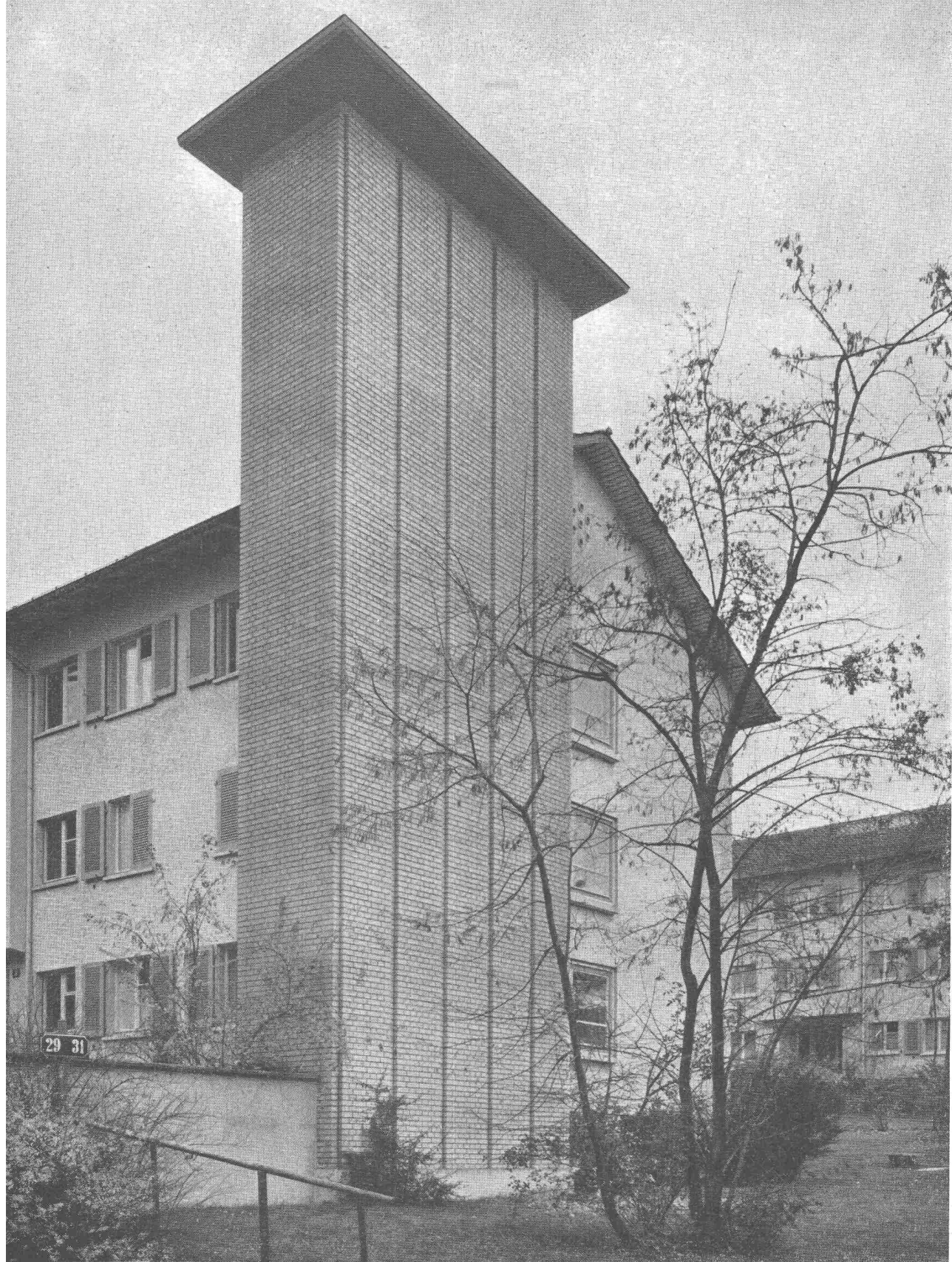
5-Züger Kamin einer Heiz- und Warmwasserzentrale
