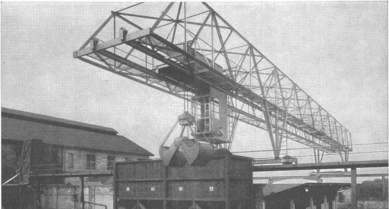
Verladebrücke in Schweisskonstruktion 2,5 t Tragkraft, 46 m Länge
