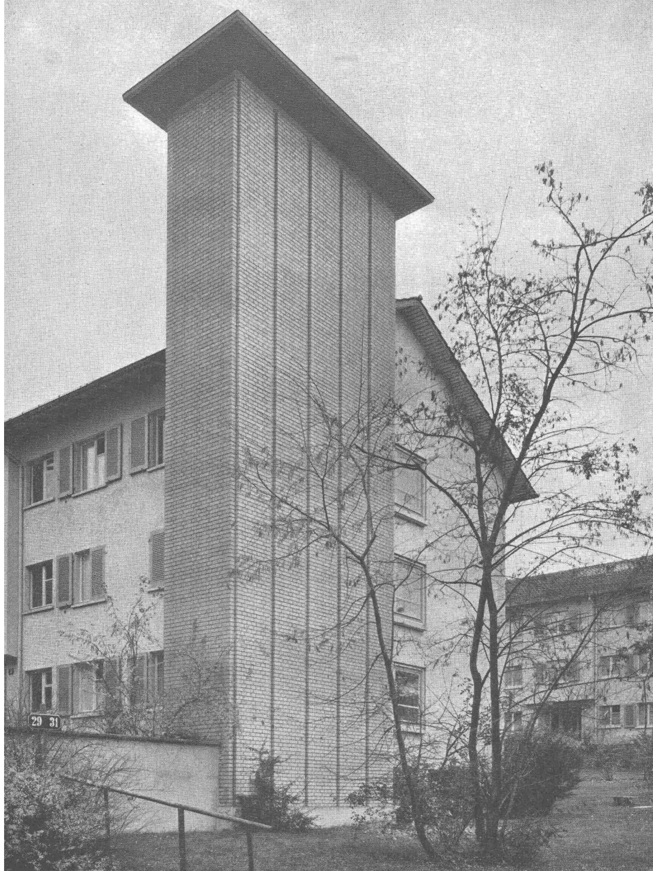
5-Züger Kamin einer Heiz- und Warmwasserzentrale
