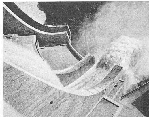
Bild 98. Hochwasser-Entlastung im Betrieb
