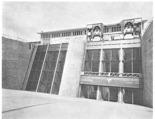
Bild 26. Einlaufrechen des Maschinenhauses. Einsetzen eines Dammbalkens. 25. Juni 1952
