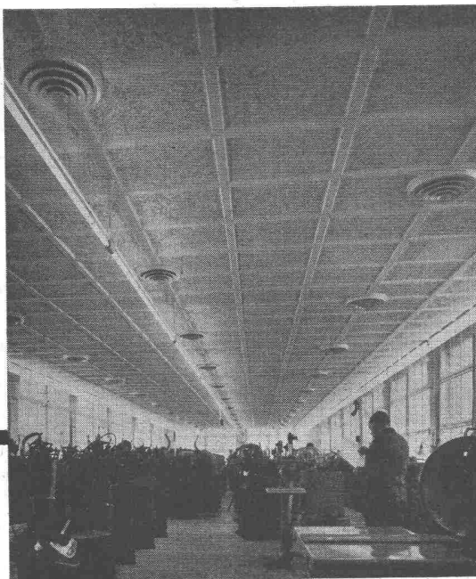
Klimaanlage „System Häusler“ in Uhrenfabrik
