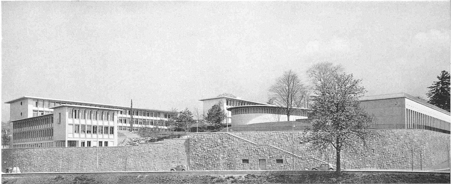
Vue d'ensemble du sud-ouest. A gauche le gymnase, au centre l'aula, à droite la salle de gymnastique
