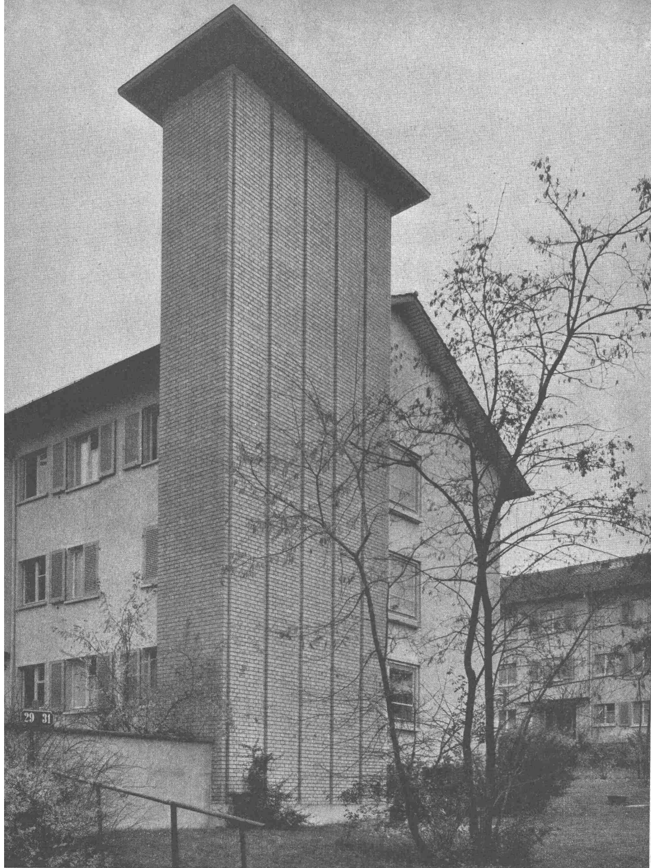
5-Züger Kamin einer Heiz- und Warmwasserzentrale
