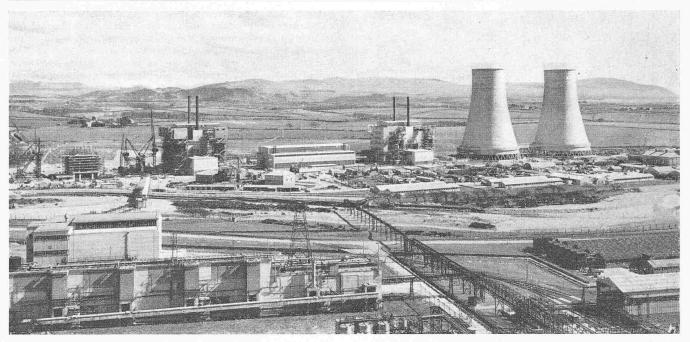
Bild 13. Gesamtübersicht der Anlage Calder Hall während des Baues. Im Mittelgrund die beiden Reaktorgebäude, dazwischen die Kraftzentrale, rechts davon die beiden Kühltürme für das Rückkühlen des Kühlwassers für die Turbinenkondensatoren, im Vordergrund Teile der chemischen Fabrik für die Regenerierung der Spaltstoffstäbe
