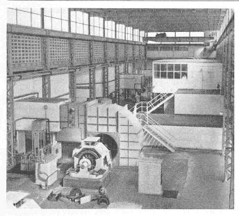
Bild 3. Maschinenhalle für die Gebläse der Anlage Windscale
