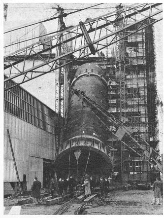
Bild 10. Montage eines Wärmeaustauschers
