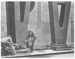
Bild 7. Montage der Tragfüsse für das Druckgefäss
