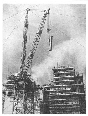
Bild 8. Reaktorgebäude im Bau; am Kran hängt ein Tragfuss für das Druckgefäss
