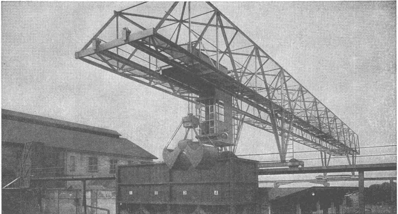
Verladebrücke in Schweisskonstruktion 2,5 t Tragkraft, 46 m Länge
