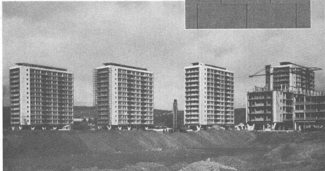
Wohnhochhäuser der Cité SNHBM Aussen- und Innenwände der 13-stöckigen Bauten in 20, 25 und 30 cm starkem Durisol-Mauerwerk und Decken aus Durisol-Hourdis.
