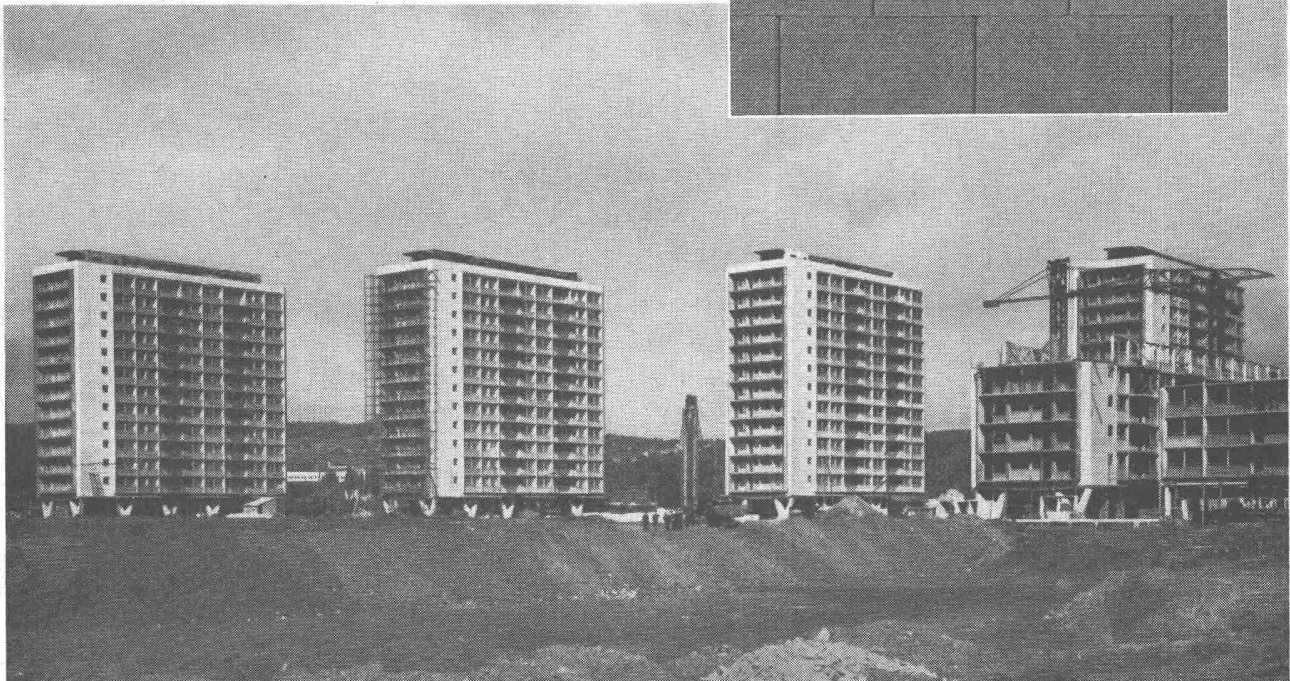
Wohnhochhäuser der Cité SNHBM
