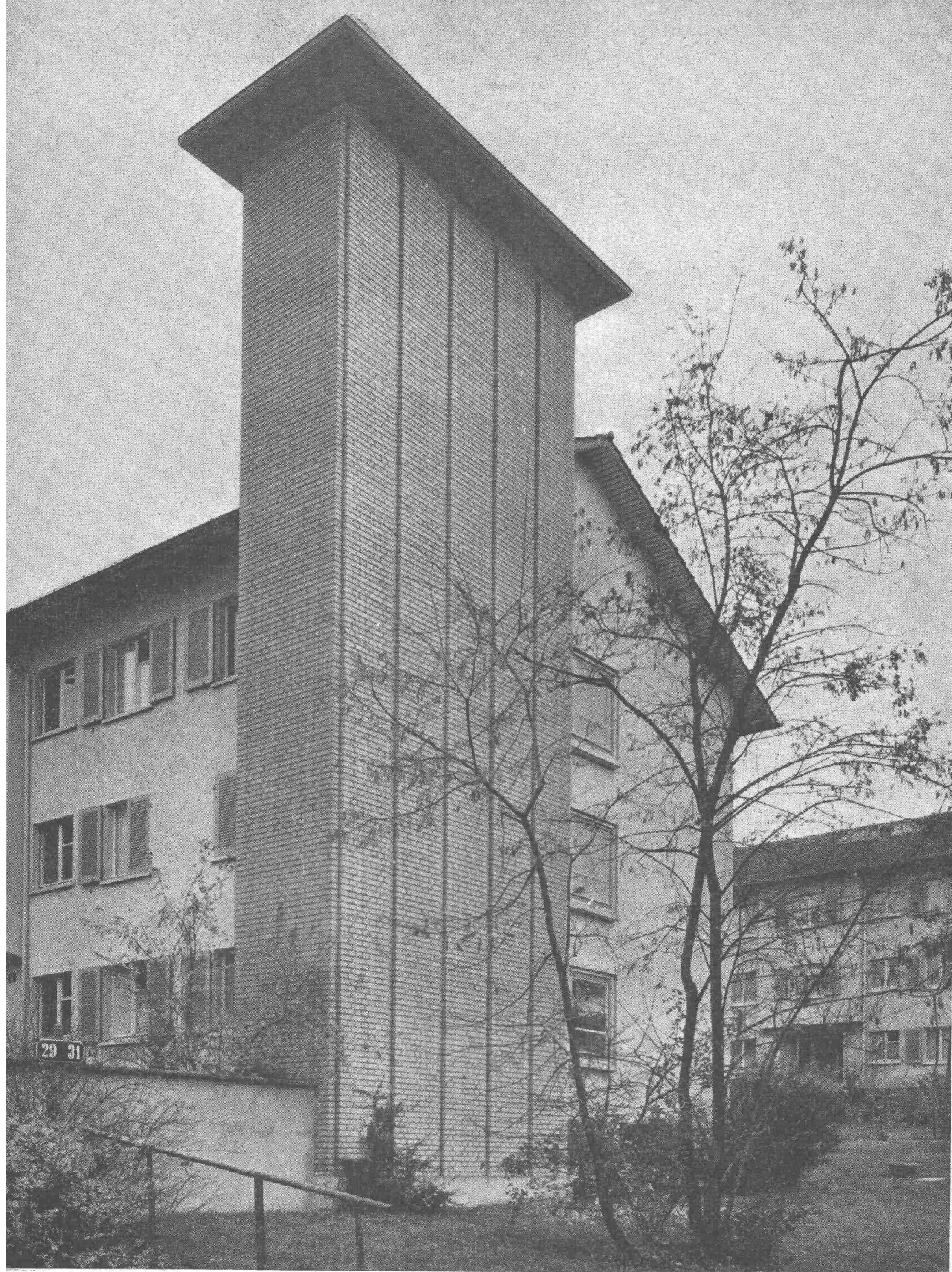
5-Züger Kamin einer Heiz- und Warmwasserzentrale
