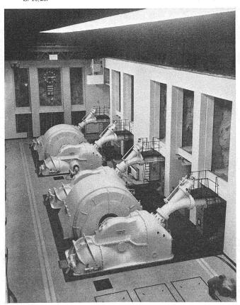
Bild 60. Zentrale Montpezat mit Escher-Wyss-Turbinen und Oerlikon-Generatoren
