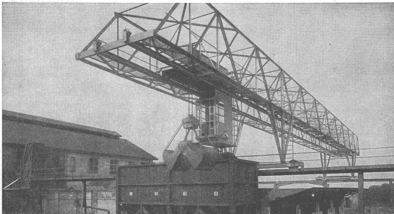
Verladebrücke in Schweisskonstruktion 2,5 t Tragkraft, 46 m Länge
