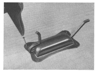
Die Dübelboxe wird mittels 2—4 Drahtstiften auf die Verschalung genagelt
