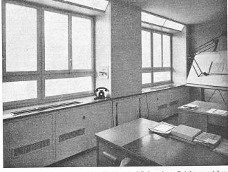
Bild 5. Klimakonvektoren, in die Fensterbänke eines Zeichnungsbüros eingebaut
