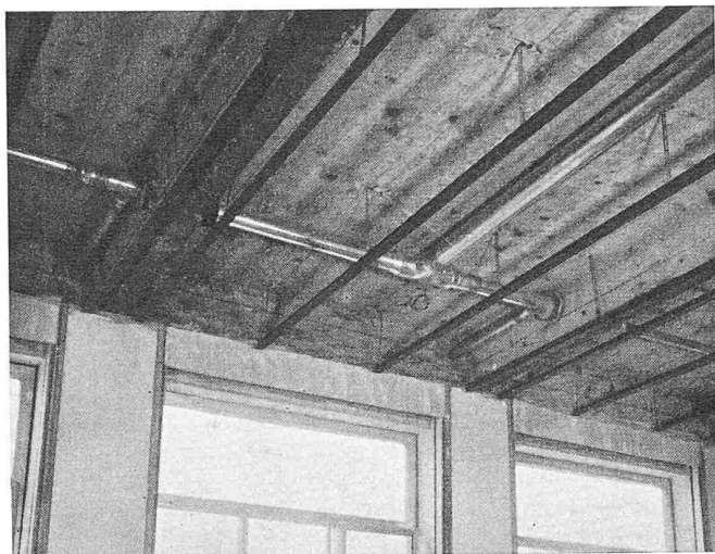
Bild 4. Leitungen für die Primärluft zu den Klimakonvektoren in der Doppeldecke verlegt
