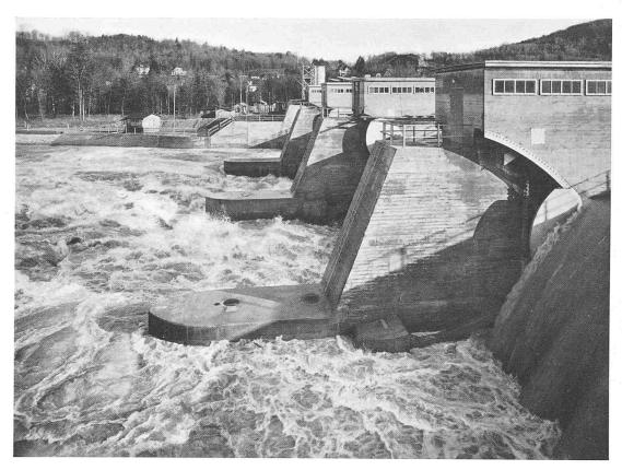
Bild 15. Hochwasserabfluss durch das Stauwehr am 28. November 1952, Wasserführung der Aare 650 m³/s
