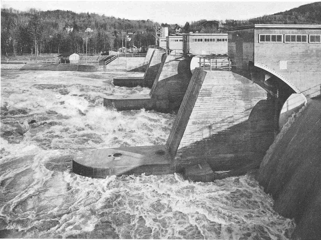
Bild 15. Hochwasserabfluss durch das Stauwehr am 28. November 1952, Wasserführung der Aare 650 m 3 /s
