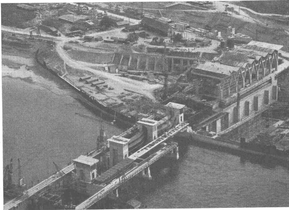
Kraftwerk Birsfelden, erbaut unter Verwendung von PLASTIMENT und FRIOPLAST
