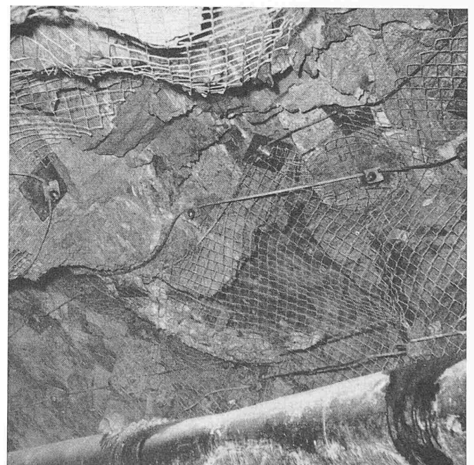
Bild 10 (links). Felsanker-Ring zur Sicherung der Firste
