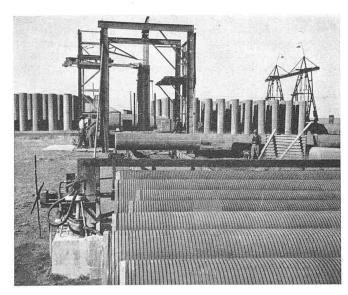
Bild 26. Vorspannen von Betonrohren auf einer Baustelle in Südafrika
