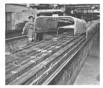
Bild 30. Elektrische Heizung für die Fabrikation von Stahlton-Produkten
