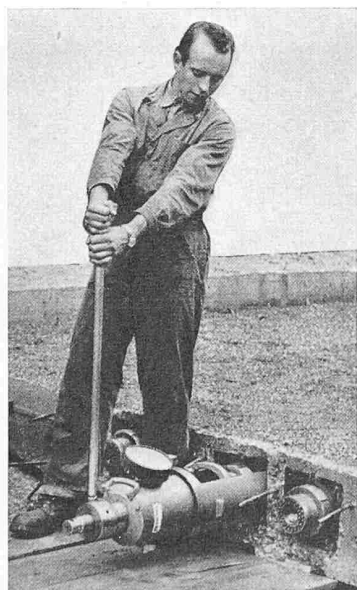
Bild 18. Vorspanneinrichtung BBRV für 100-Tonnen-Spannglieder mit angebaute Handpumpe
