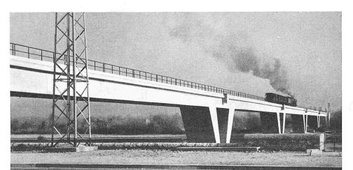
Bild 1. Eisenbahnbrücke über die Rhône bei La Voulte (Frankreich). Länge  $= 5 \times 60$  m. vorgespannt nach Verfahren BBRV. Ausführliche Beschreibung dieses Baues siehe «Travaux» vom September 1956
