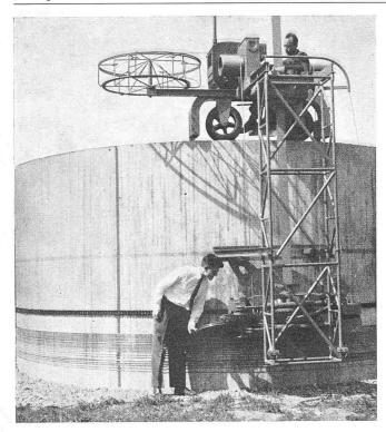
$\operatorname{Bild}$  23. BBRV-Behälterwickelmaschine  $\operatorname{mit}$  Fachwerk-Führungskonstruktion
