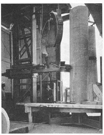
Bild 25. BBRV-Rohrwickelmaschine
