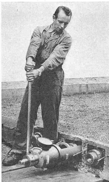
Bild 18. Vorspanneinrichtung BBRV für 100-Tonnen-Spannglieder mit angebaute Handpumpe
