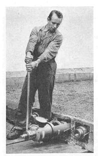
Bild 18. Vorspanneinrichtung BBRV für 100-Tonnen-Spannglieder mit angebauter Handpumpe
