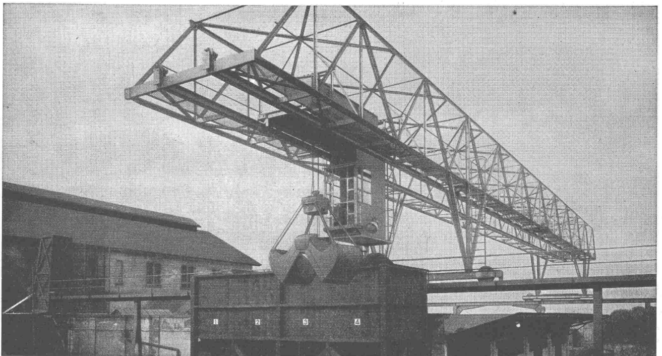
Verladebrücke in Schweisskonstruktion 2,5 t Tragkraft, 46 m Länge
