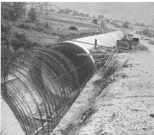
Bild 46. Die Druckleitung \varnothing 6,4 m aus Eisenbeton
