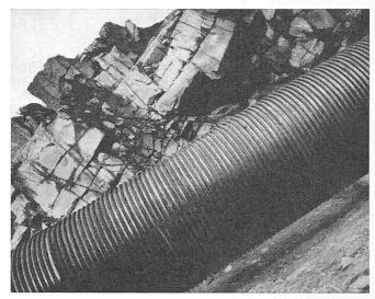
Bild 38. Druckleitung mit Verstärkung durch Seilschlaufen
