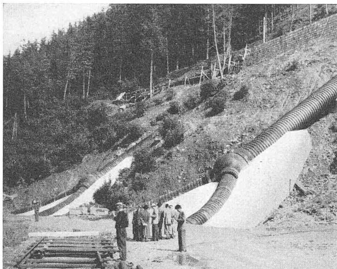
Bild 39. Kugelförmige Verteilstücke nach G. Ferrand, von 3,2 m Innendurchmesser
