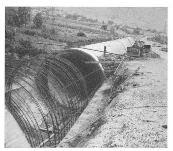
Bild 46. Die Druckleitung  $\phi$  6,4 m aus Eisenbeton
